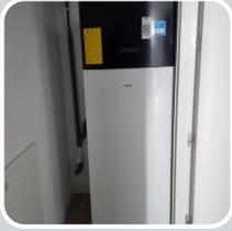
Sistema de climatización con bomba de calor Altherma de Daikin con suelo radiante y refrescante
